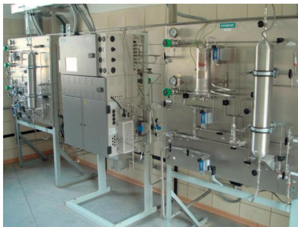
*Аналитические системы ОАО «Казаньоргсинтез». Реализованы на базе потоковых хроматографов с системами подготовки пробы. Оперативное определение концентраций позволяет автоматически вносить управляющие воздействия в технологический процесс.*
