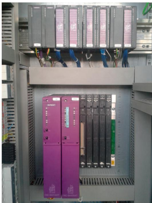
Программно-технический комплекс «ГКС-Зилант» выпускается по техническим условиям «ГКСК.421452.016 ТУ» и является отечественной локализацией платформы автоматизации SIMATIC PCS7 фирмы Siemens – наиболее производительной и функционально полной линейки систем управления непрерывными и периодическими процессами.
