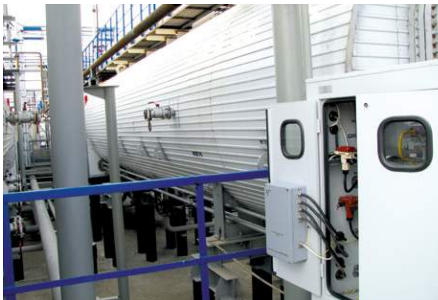
Ультразвуковой генератор «Акустик-Т4» (серый справа внизу) на подогревателе нефти
