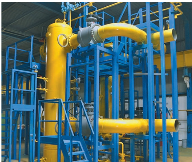
Фото 2. Блок фильтров-коалесцеров газа
